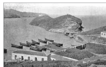
Εικόνα 4. Η ανθρακαποθήκη της Κόκκας και οι φορηγίδες που μετέφεραν το κάρβουνο από τα φορηγά στη στεριά και από την αποθήκη στα ατμόπλοια. ( The Zea Coaling Company, ό.π., σ. 37 ).
